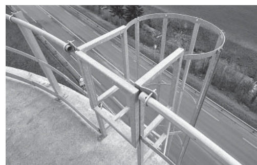
Bild 5: Sichere Gestaltung des Leiterausstiegs mit selbstschliessender Durchgangssperre. Die Leiterholme reichen bis auf die Höhe des Geländerhandlaufs.
