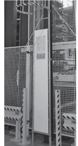
Bild 2: Ortsfeste Leiter mit Rückenschutz. Die Leiter ist mit einer abschliessbaren Sperre gegen unbefugtes Begehen gesichert.
