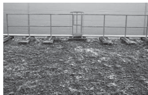
Bild 6: Geländer als Absturzsicherung auf beiden Seiten des Leiterausstieges entlang der Sturzkante.
