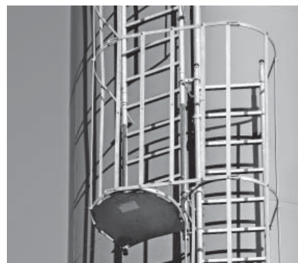
Bild 10: Umsteigebühne an zusammengesetzten Leiterzügen. Das Podest der oberen Leiter muss min. 70 cm breit sein und die Korbfläche ausfüllen.
